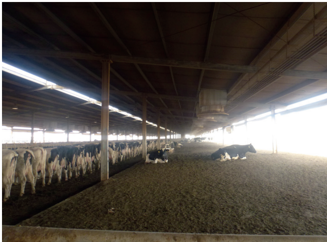
Foto 3. Allevamenti diversi sistemi di ventilazione e raffreddamento diversi. In questo caso raffreddamento e ventilazioni realizzati tramite un sistema che spinge delle micro gocce sugli animali.
